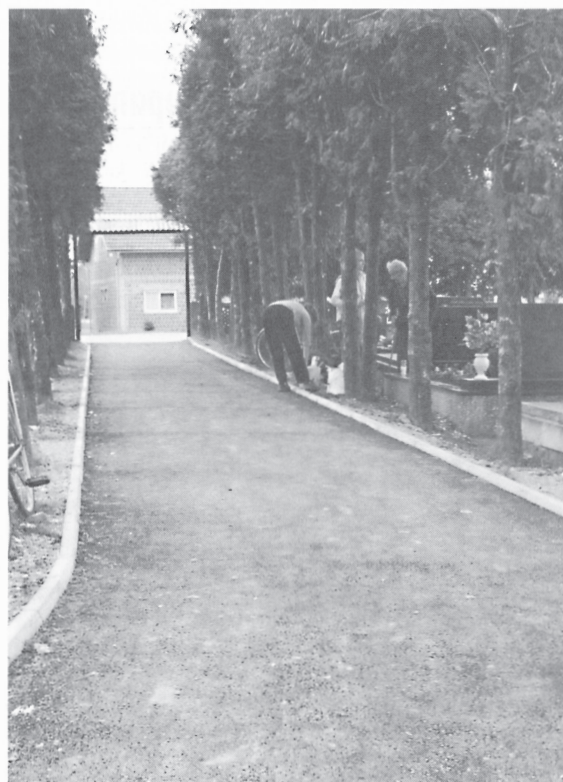
Staza na groblju u Jalševcu Nartskom asfaltirana još prije Svih svetih
