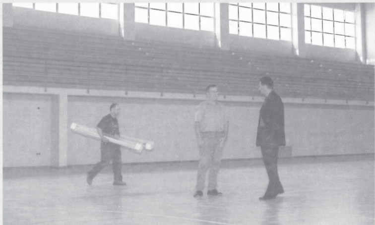
Unutrašnje uređenje dvorane u završnici - uređena tribina i postavljen parket
