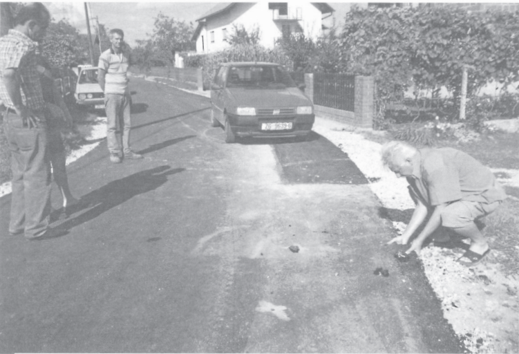
Nakon svega par dana asfalt je već popravljan, a ostali dio lako se rukom može podići i rastrgati u komade
