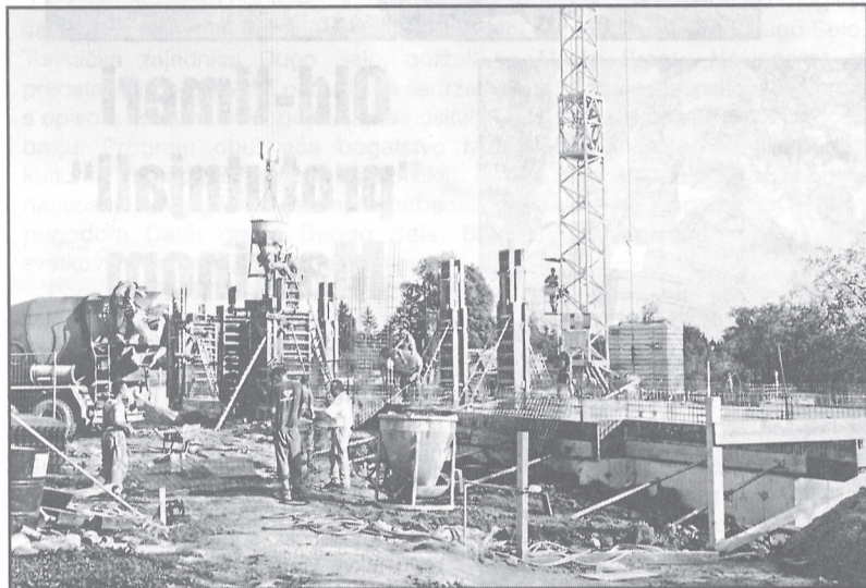
Napreduje gradnja nove zgrade doma zdravlja
