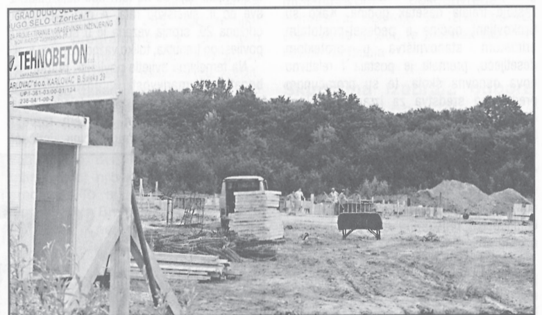
Započeta gradnja dvorane još je u fazi zemljanih radova
