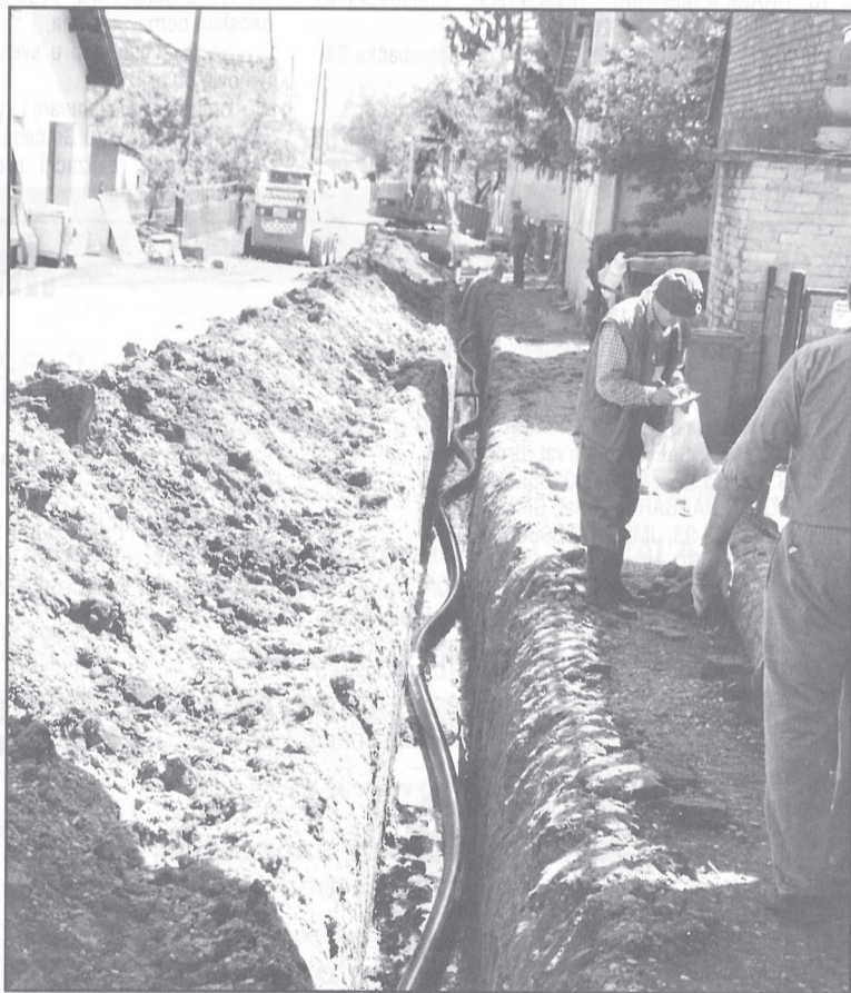
Postavljanje uličnog cjevovoda u Antoljakovoj ulici
