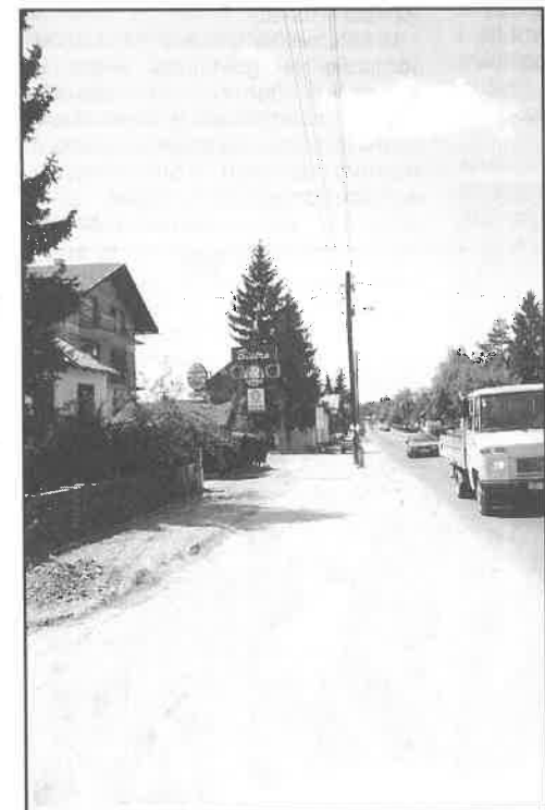
Prostor pločnika u Zagrebačkoj ulici priprema se za asfaltiranje
