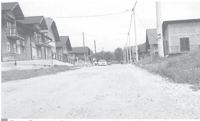
Do asfaltiranja ulice u novom naselju u Dugom Selu navožene kamenim agregatom
