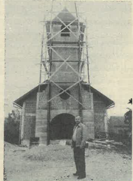
Završeni grubi građevinski radovi na kapelici Sv. Nikole Tavelića u Sopi
