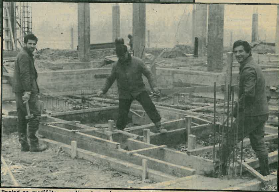
Pogled na gradilište – radi se i na minus pet stupnjeva
