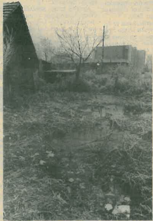
Smrad, nečistoća i močvara podno zgrade sa više desetaka stanova
